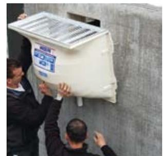
4. Lichtschacht mit Rost an den Fixankern einhängen und leicht anschrauben.
