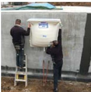
1. Rost einhängen und Grundlöcher anreißen, bohren und Fixanker einschlagen
