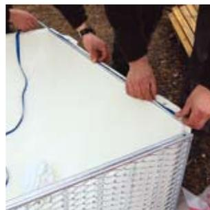
2. Abdichtungsband in die Aufnahme- nut des Lichtschachtes einkleben
