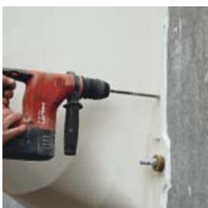
5. Zusätzliche Befestigungslöcher je nach Vorgabe der Bohrlöcher im Schienenset bohren.
