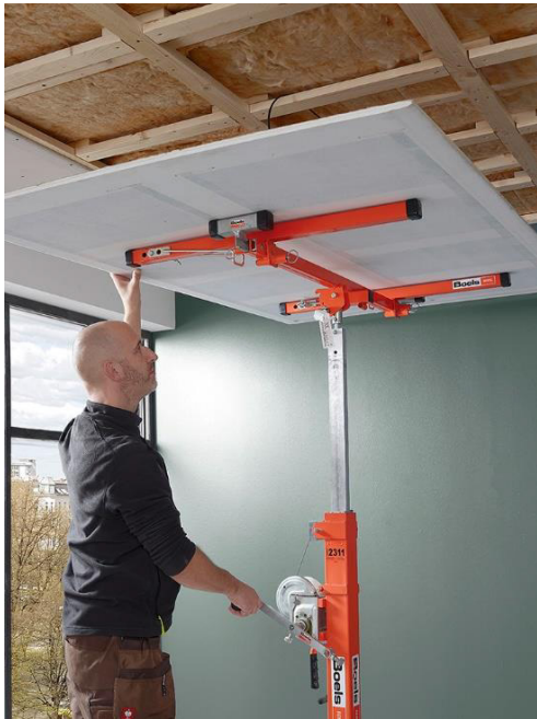
Abbildung 3: Montage der eThermoHeld • WAND • an der Decke mit Plattenheber
