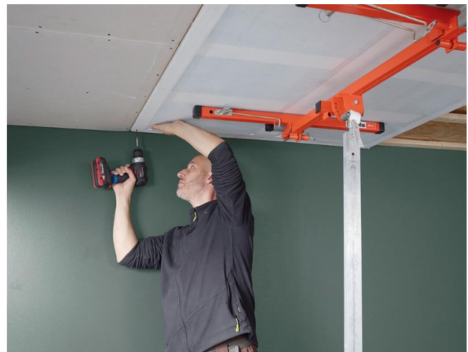
Abbildung 3: Montage der eThermoHeld • WAND • an der Decke mit Plattenheber
